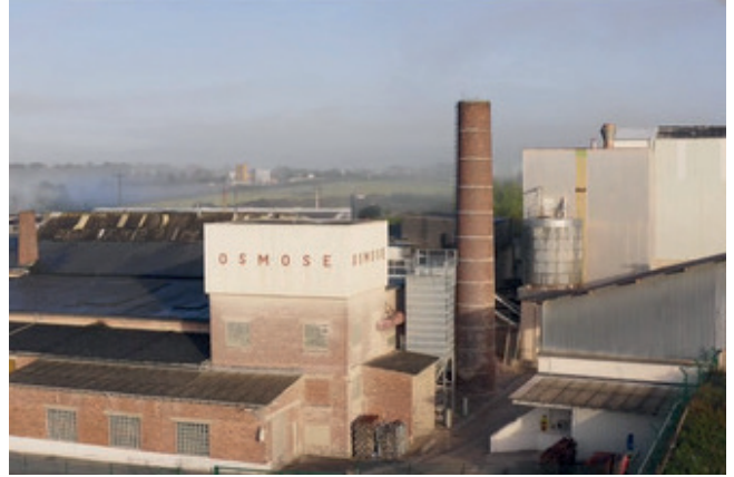
Werk Elektro Osmose, Westerwald, Deutschland
